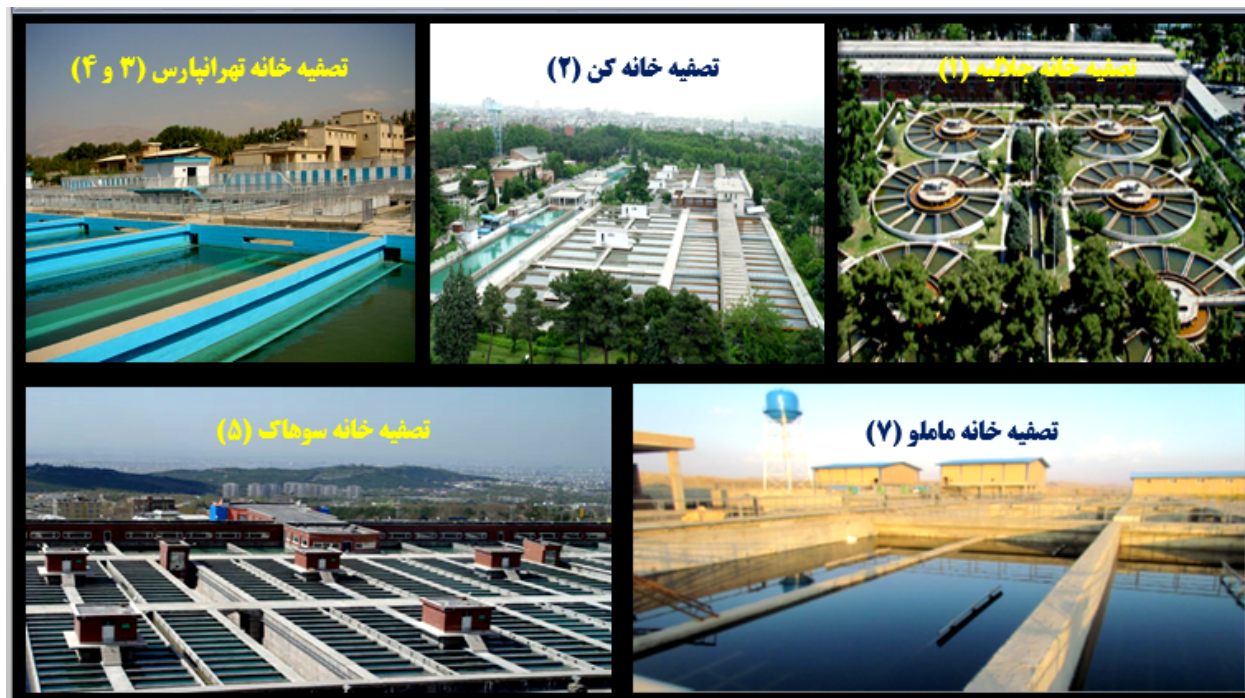
تصویر ۳-۳ تصفیه‌خانه‌های شهر تهران
