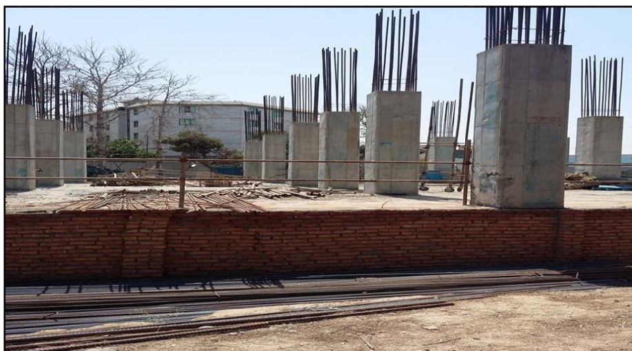
تصویر ۲-۱۸ احداث کلینیک ویژه بیمارستان مهدیه
