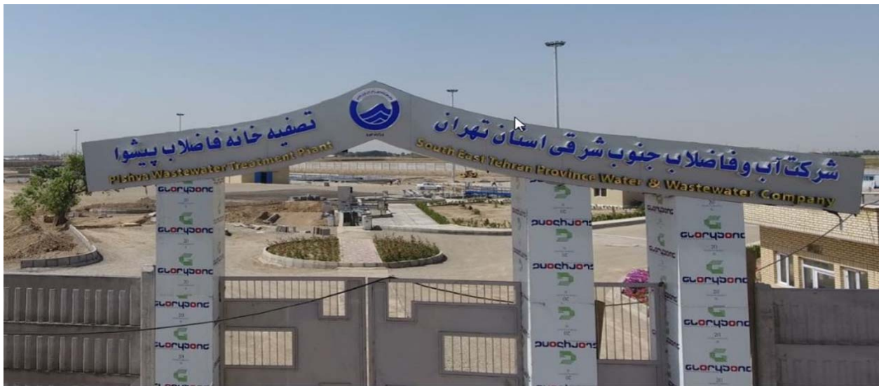
تصویر ۳-۳ احداث تصفیه خانه فاضلاب شهر پیشوا
