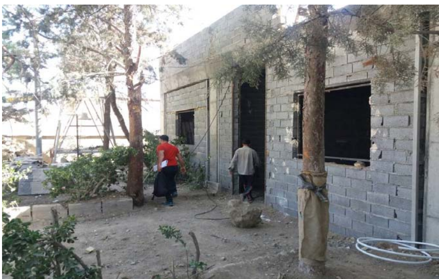
تصویر ۲-۲ پروژه احداث خانه بهداشت باغمیش پردیس
