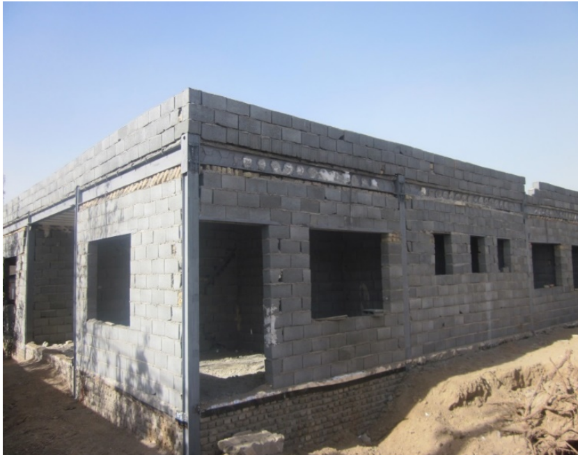
تصویر (۲-۴): پروژه احداث مرکز خدمات جامع سلامت درمانی ابراهیم آباد پاکدشت
