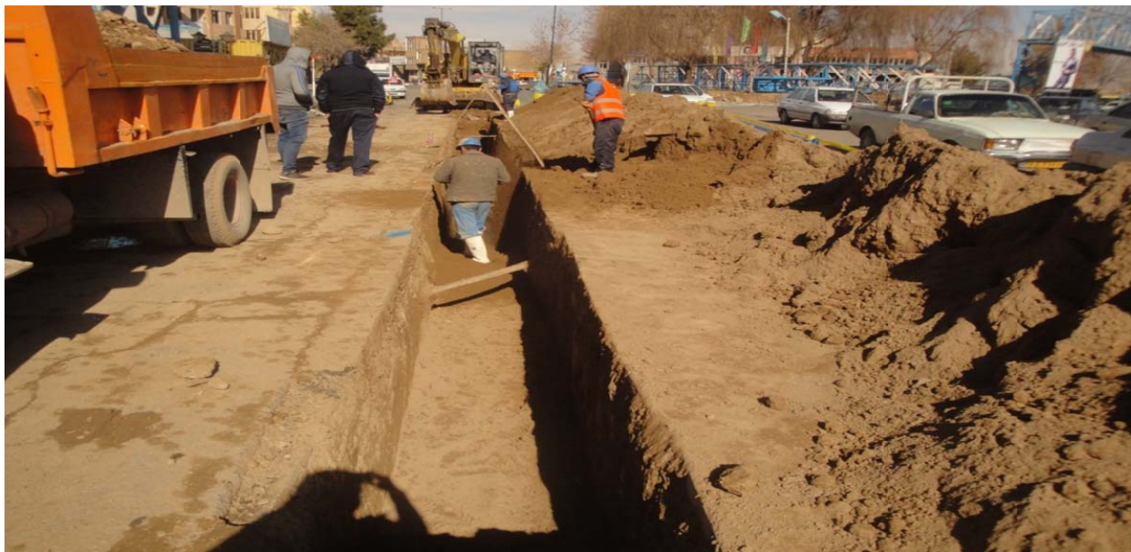
تصویر (۳-۳): پروژه اصلاح و بازسازی شبکه توزیع آب آشامیدنی در سطح شهرستان پاکدشت
