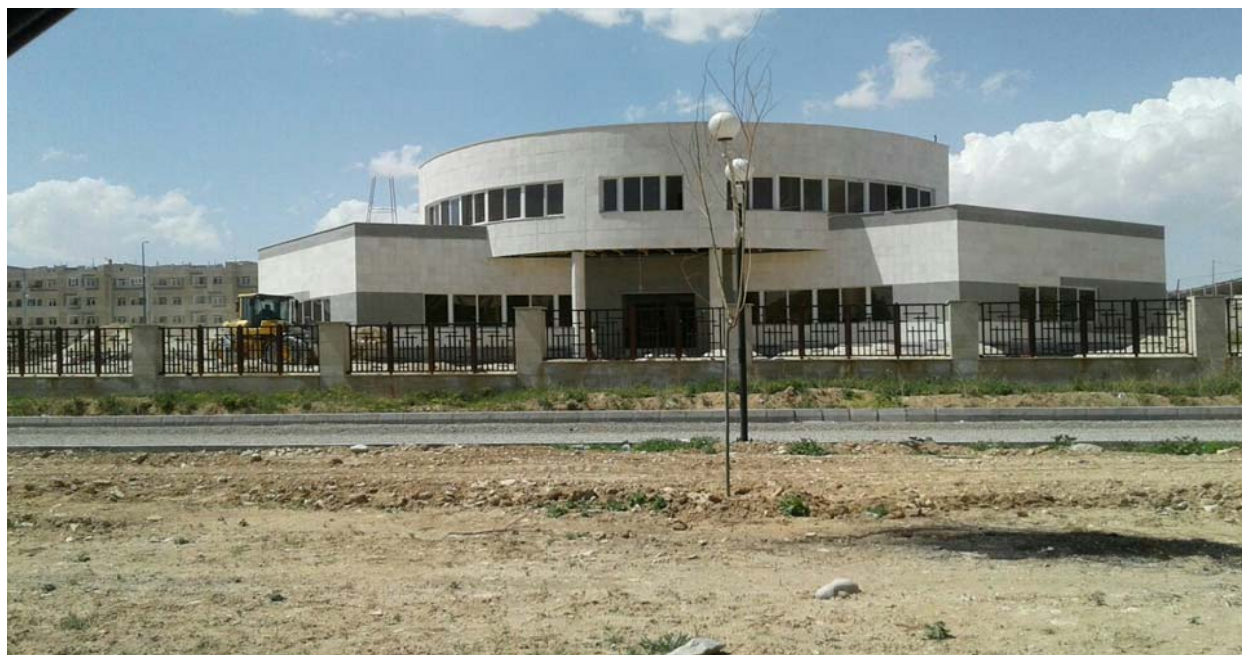
تصویر (۲-۳): پروژه احداث کلینیک ویژه بیمارستان امام خمینی (ره) فیروزکوه
