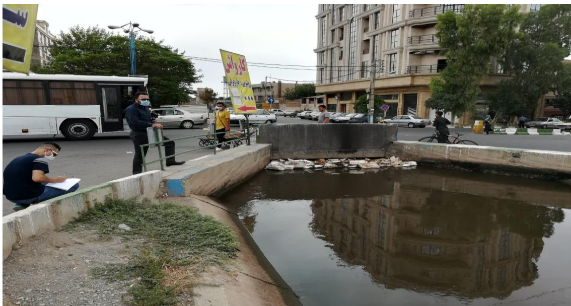
شکل ۳-۱۲. عبور کانال انتقال پساب تصفیه‌خانه شهری از داخل شهر پاکدشت
