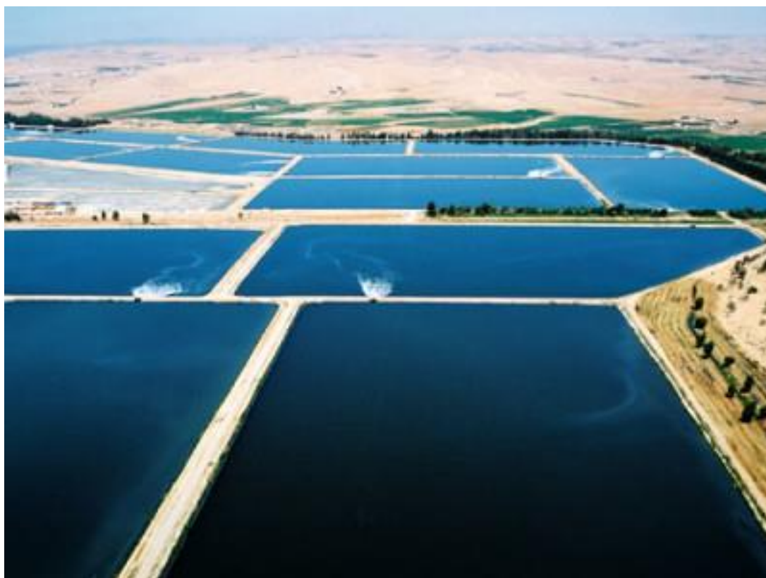
شکل ۲-۱. نمونه‌ای از برکه‌های تثبیت فاضلاب
