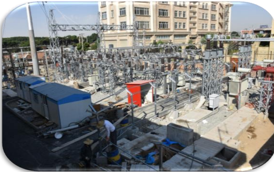
تصویر ۴-۴ - پست ۶۳/۲۰ کیلوولت کارون
