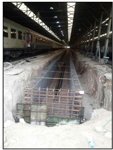
تصویر ۴-۲۹- بازسازی خطوط ۱ و ۲ و ساخت چاله سرویس در خطوط ۴ و ۶ واگن خانه ایستگاه تهران به طول ۲۰۰۰ متر
