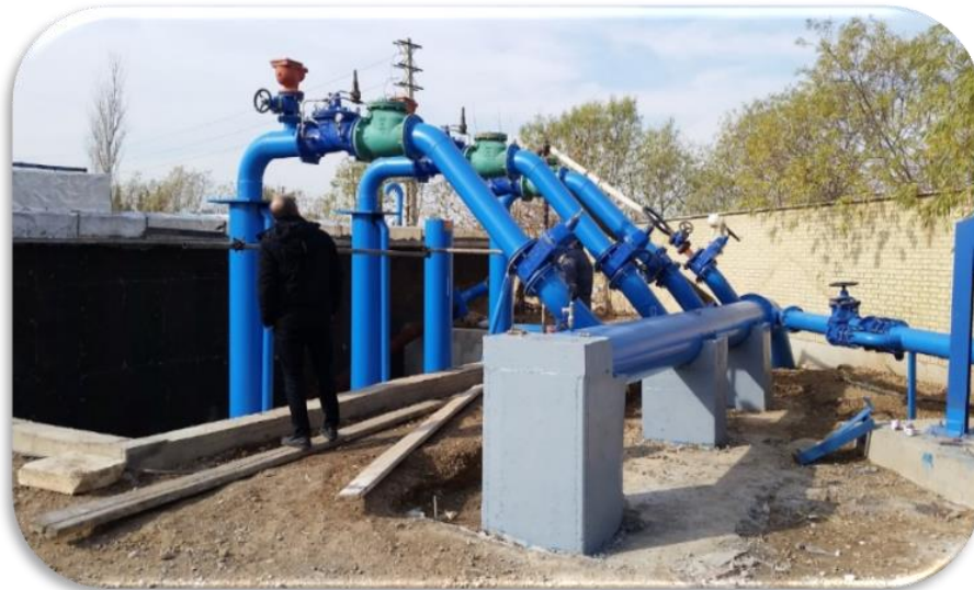
تصویر ۳-۴۴- اجرای ایستگاه پمپاژ مجتمع شهید تهرانی
