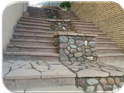
بعد از اجراء
