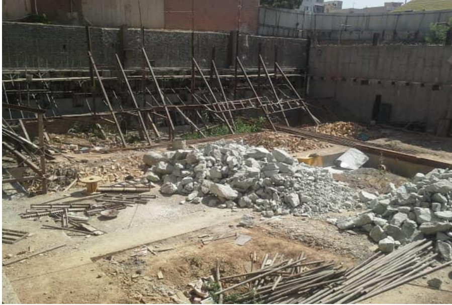
تصویر ۲-۷- احداث مجتمع ورزشی طبقاتی هویزه منطقه ۱۶ تهران
