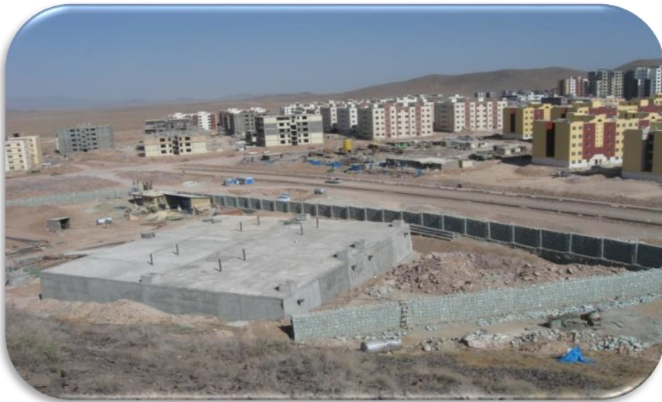
تصویر ۳-۳۵- مخزن ۳-R پرند با حجم ۵ هزار متر مکعب
