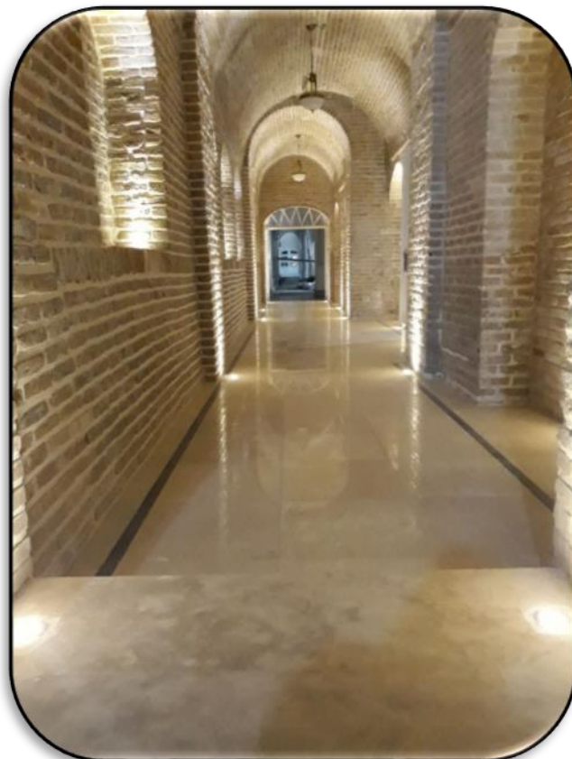
تصویر ۲-۴۱-مرمت راهروی شرقی عمارت اصلی انجمن مفاخر و آثار فرهنگی
