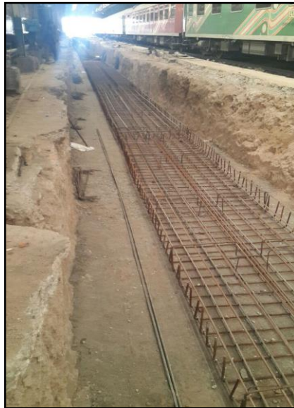
تصویر ۴-۲۹- بازسازی خطوط ۱ و ۲ و ساخت چاله سرویس در خطوط ۴ و ۶ واگن خانه ایستگاه تهران به طول ۲۰۰۰ متر
