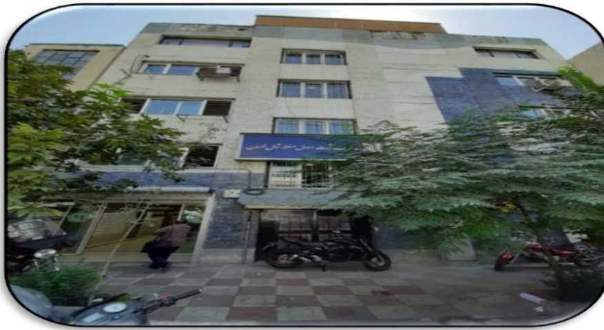
تصویر ۲-۴۳- اداره ثبت احوال منطقه شمال
