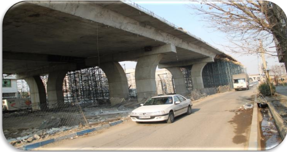
تصویر ۱-۶- پل غیر همسطح ورودی شهر قدس
