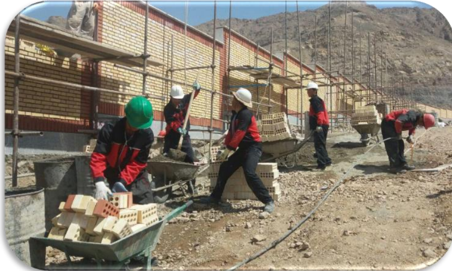
تصویر ۳-۴۵- احداث مخزن بتنی زمینی ۲۰۰۰ مترمکعبی، احداث ساختمان، دیوار کشی و محوطه سازی تأسیسات آبرسانی مجتمع شهید تهرانی (ری)
