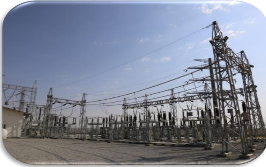
تصویر ۳-۴ - پست ۴۰۰/۶۳ کیلوولت مدولار کوثر
