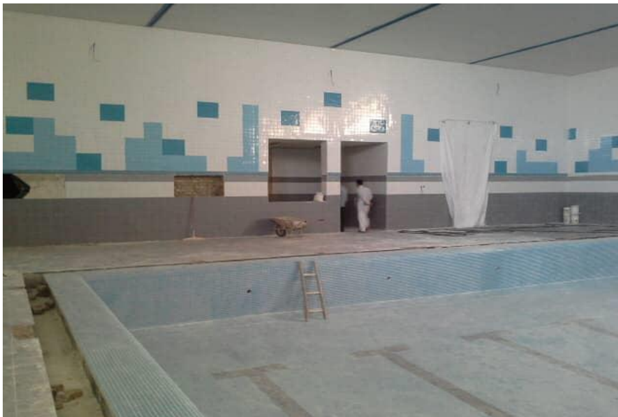
تصویر ۲-۸- احداث استخر سرپوشیده شهدای دارآباد
