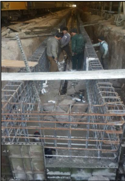
تصویر ۴-۲۹- بازسازی خطوط ۱ و ۲ و ساخت چاله سرویس در خطوط ۴ و ۶ واگن خانه ایستگاه تهران به طول ۲۰۰۰ متر
