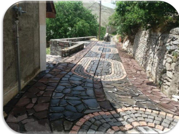
بعد از اجراء
