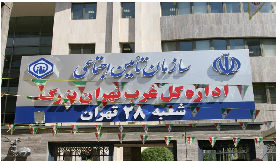
تصویر ۲-۱۳- ساختمان جدید شعبه ۲۸
